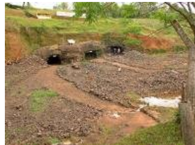
Vista galerías de la Mina Selva Irupé.
