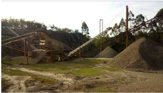
Planta de trituración. Cantera Nedel.
